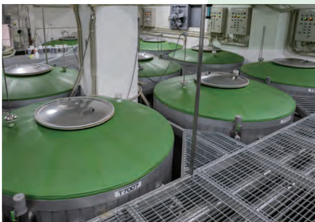
現代の設備が備わったタンクでは、1台1台丁寧に温度管理されて日本酒が仕込まれています
